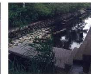
豊かな水辺の1つになっている現在の水路
